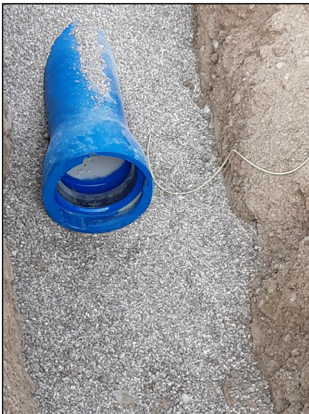
Campione indicativo di tubazioni in ghisa per acquedotto
