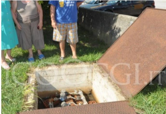
Figura 4 contatori in pozzetto con lamiere di copertura
