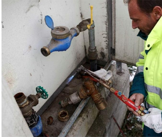
Figura 7 lavorazioni particolari con fiamma
