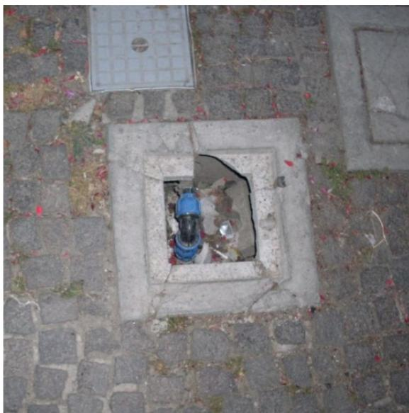
Figura 10 risanamento pozzetto ed eventuale allargamento
