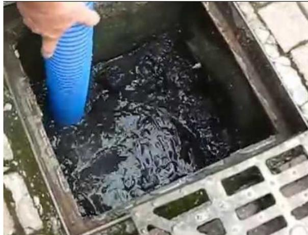
Figura 8 pulizia pozzetto con autospurgo
