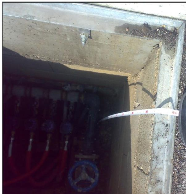
Figura 6 pozzetti profondi con più contatori
